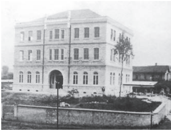
Edifício Mackenzie recém-construído
