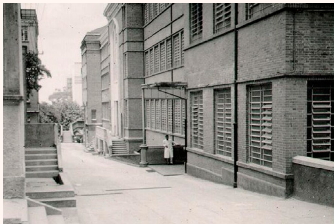
Corredor da Escola de Engenharia
