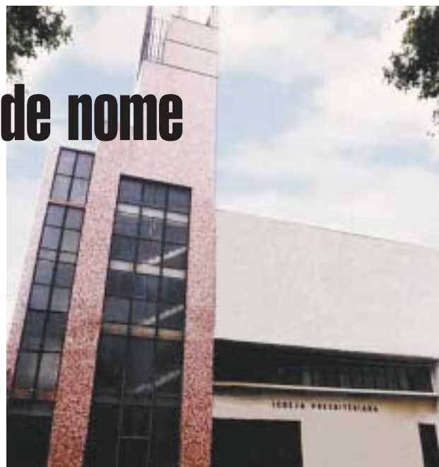
Templo reformado da Primeira IP de Bauru
