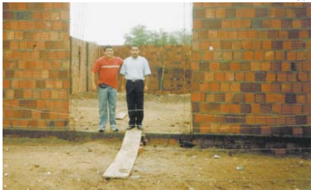
Obras do templo da IP de Exu
